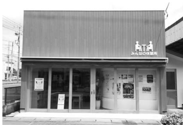
みんなの休憩所【改修後】
