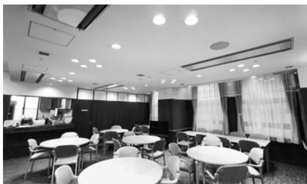
LED 照明へ切り替えが済んだ食堂
